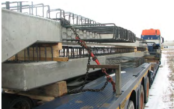
Figura 158 Transportarea prefabricatelor pe șantier
