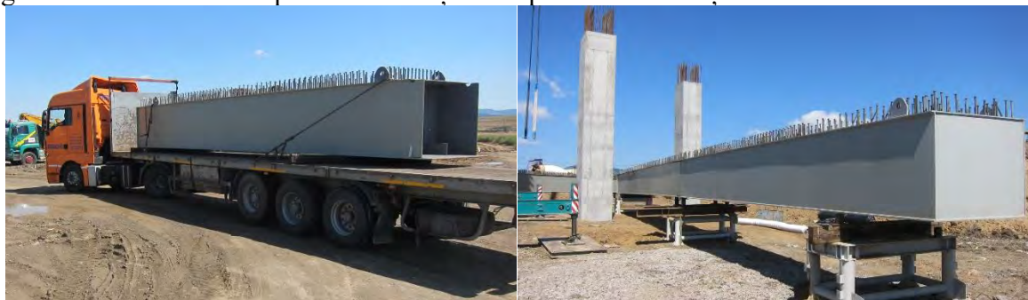
Figura 164. a) Transportarea tronsoanelor de grinzi pe șantier, b) Sudarea tronsoanelor
