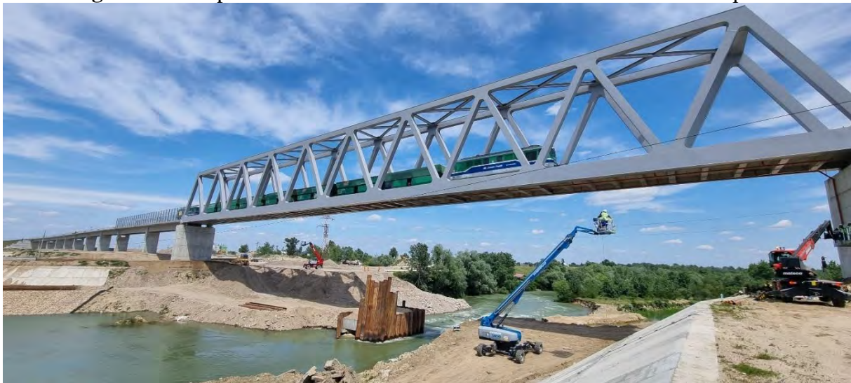
Figura 71. Încercare cu convoi de probă
