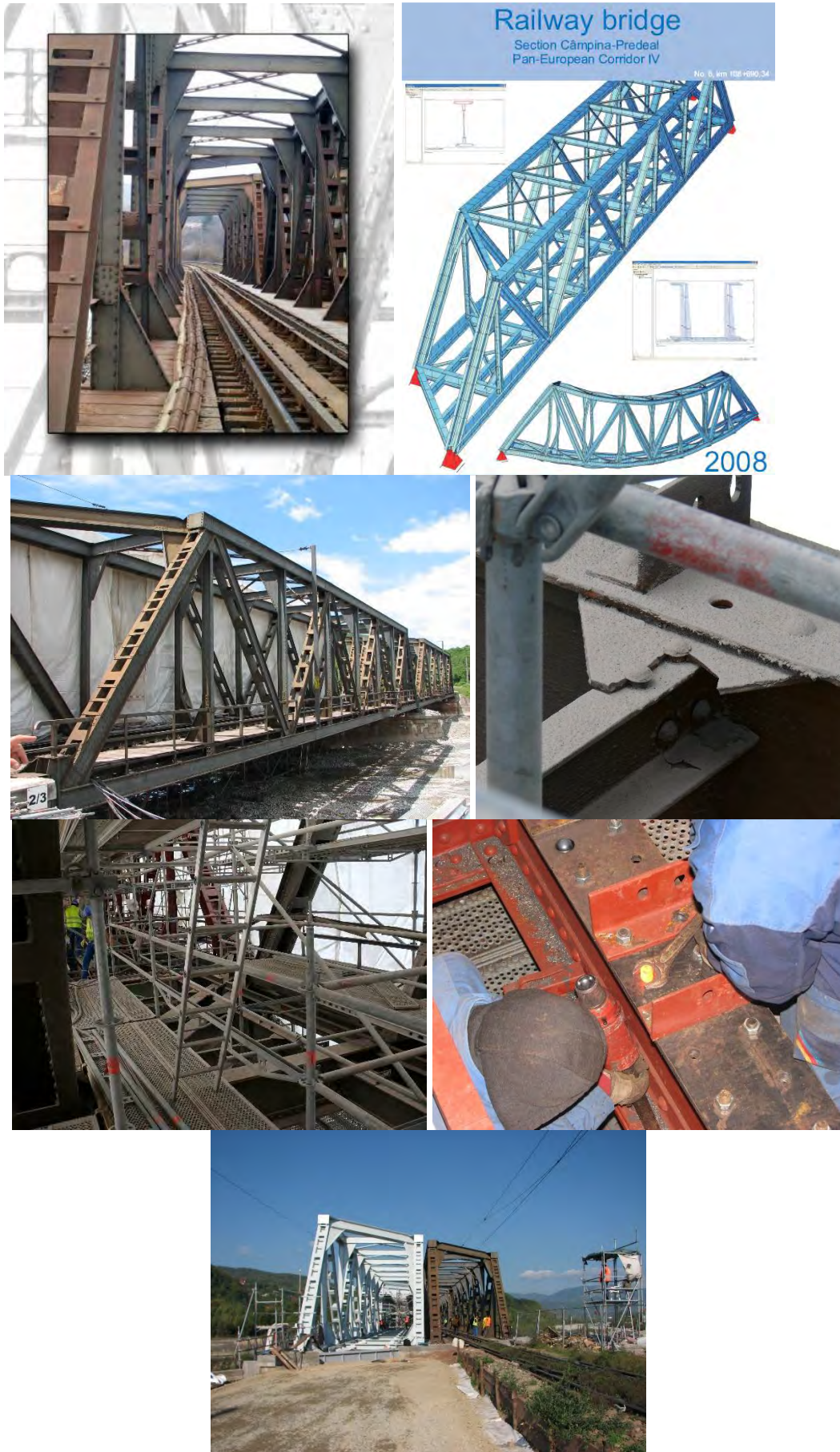
Figura 54. Reabilitare pod metalic CF nituit (an de construcție 1940)
