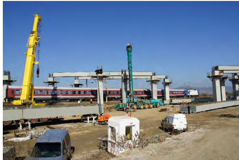
Figura 165. Ridicarea grinzilor din oțel pe infrastructuri
