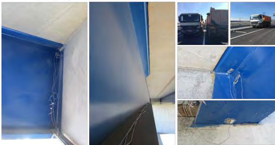
Figura 105. Instalarea timbrei tensiometrice
