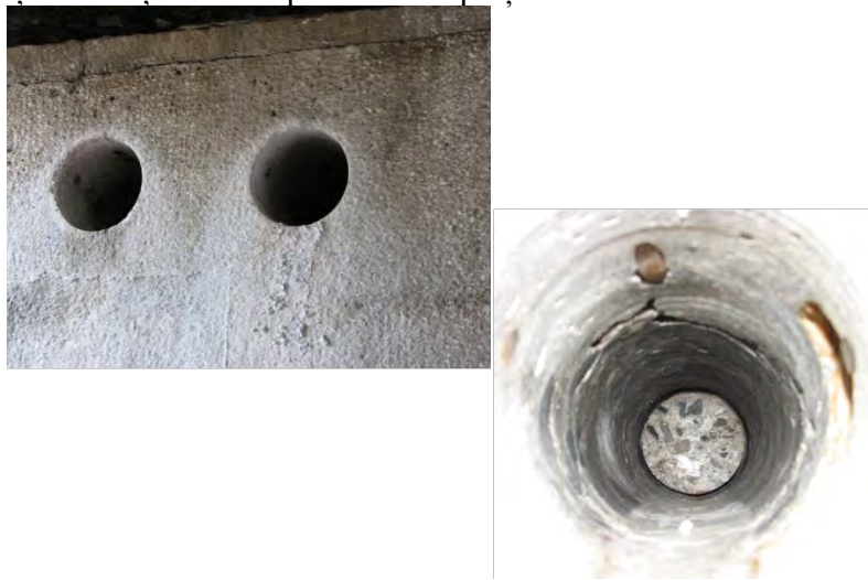
Figura 53. Prelevarea de probe / carotări
