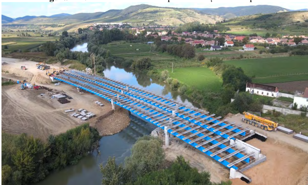
Figura 173. Podul de autostradă peste Mureș – sistem VTR rețea de grinzi în alcătuire compusă oțel – beton
