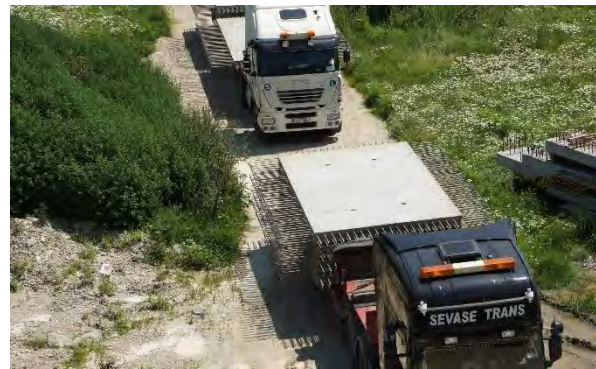
Figura 158 Transportarea prefabricatelor pe șantier
