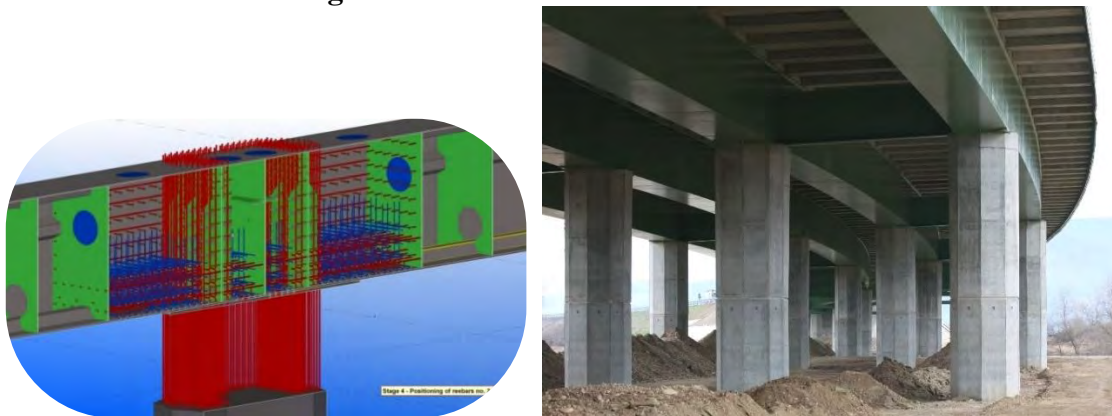
Figura 155. a) Nod pile fixe, b) Vedere de jos spre pilele „fixe”
