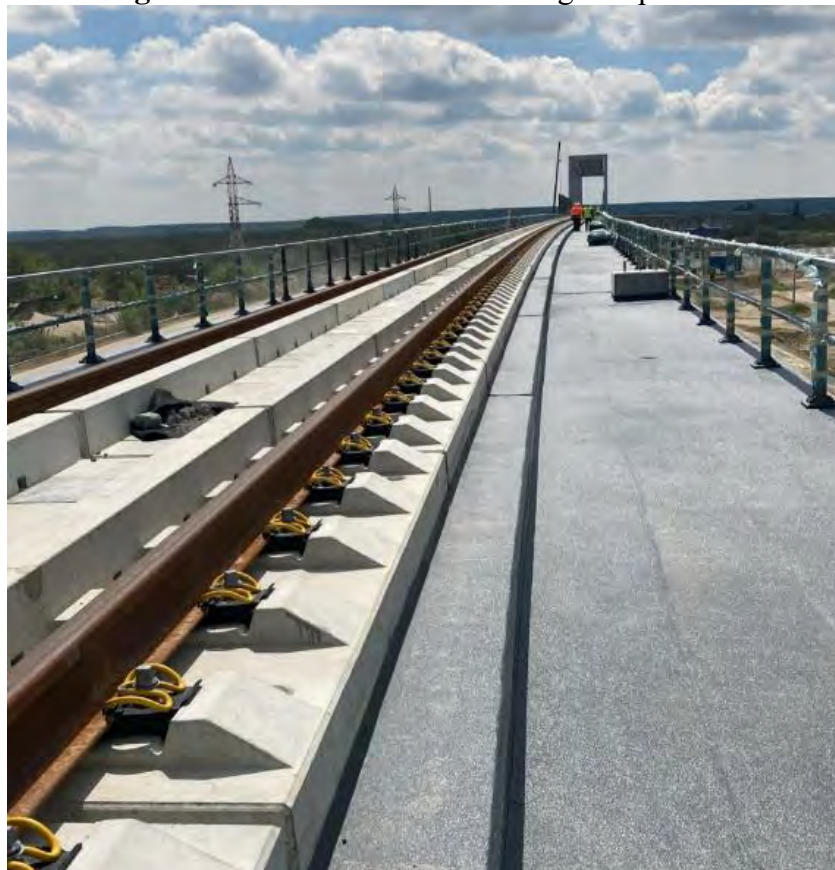
Figura 69. Cale rigidă pe viaductul CF Grădiștea
