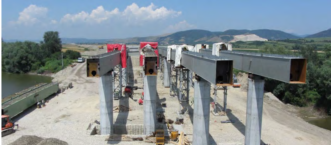
Figura 157. Montarea structurii metalice
