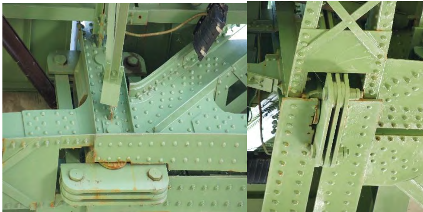
Figura 43. Sistemul de consolidare folosit la pendulul mic.
