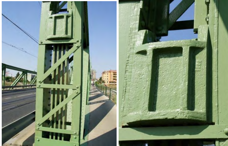
Figura 44. Consolidare pendulul mare
