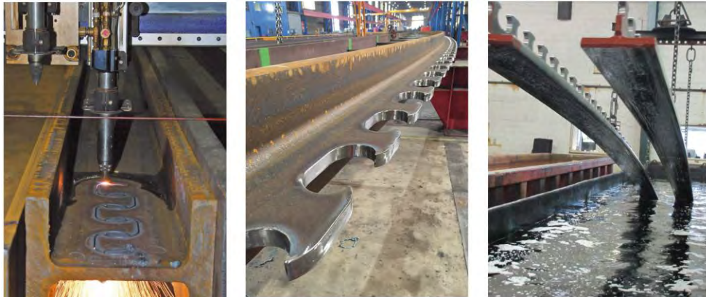
Figura 130. Armătură rigidă imersată în baia de zincare termică
