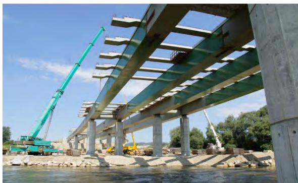
Figura 159 a) Dispunerea antretoazelor pe grinzile metalice la distanțe regulate, b) Sistemul de grinzi intermediare
