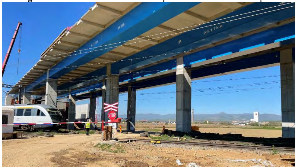
Figura 175. Viaductul de autostradă peste 3 linii CF – fotografie din șantier, execuție sub trafic
