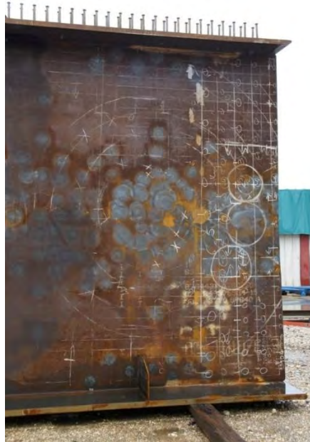
Figura 83. Imagine cu procedeul utilizat în Franța la remedierea unei inimi cu deformație mare
