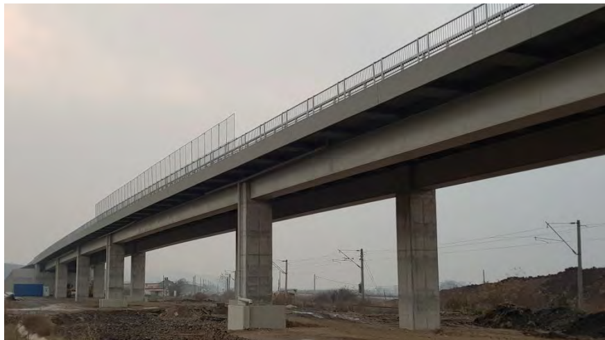
Figura 170. Pasajul rutier Simeria – Structură definitivată în așteptarea liniilor CF
